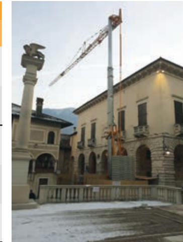
HUP 40-30 con torre telescopica h. 30 m
